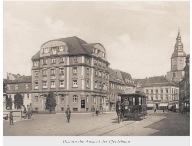
Historische Ansicht der Pferdebahn
