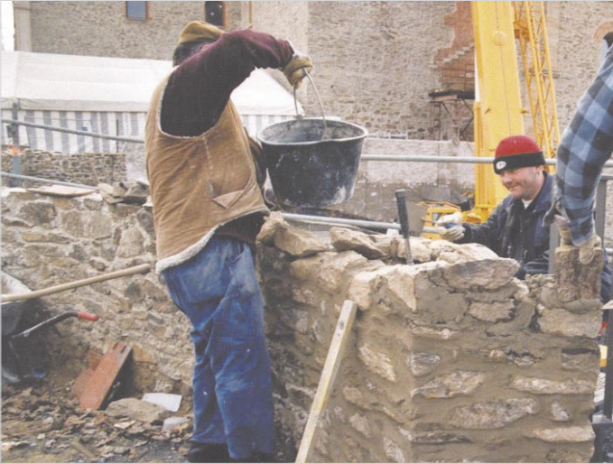
Sanierung der Schloßgrabenmauer
