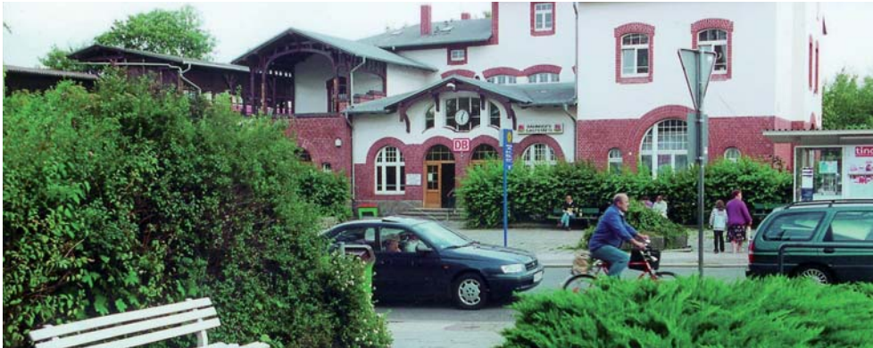
Bahnhof in Markkleeberg
